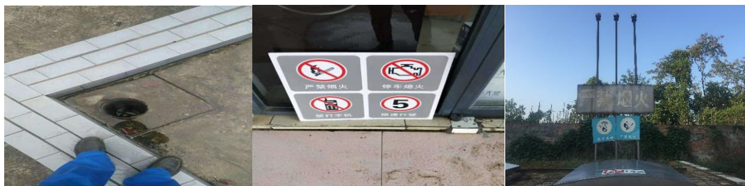
图 3-8 加油站监测井、警告牌和排放立管
