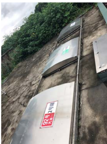
图 3-8 油罐区防渗区
