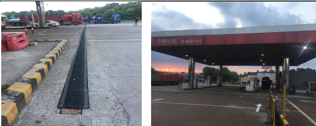
图 3-7 集水、排水设施照片
