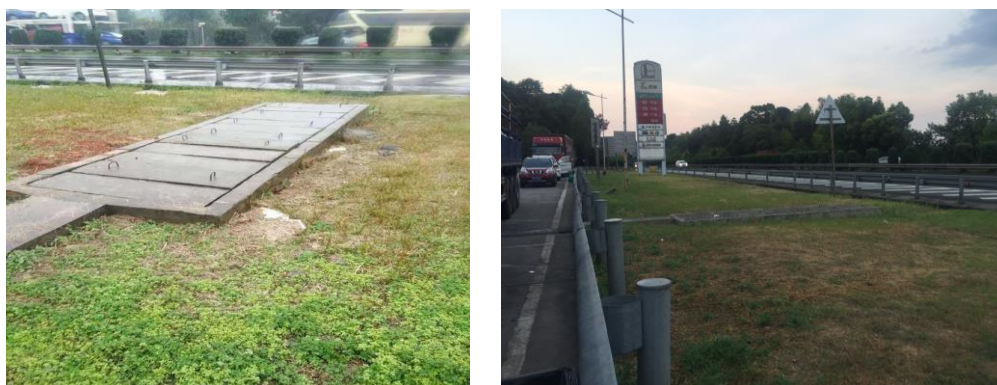
图 3-6 项目隔油池照片
