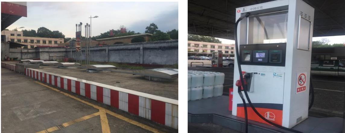
图 3-3 卸油区一次回收系统和加油机二次油气回收系统
