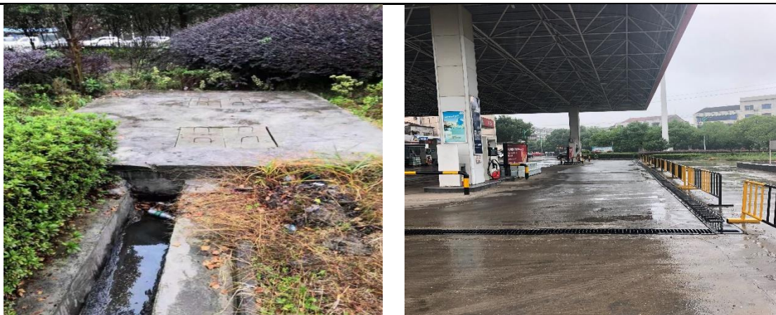
图 3-2 站区现有隔油池及集水沟
