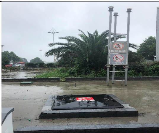
图 6-1 废气有组织排放立管
