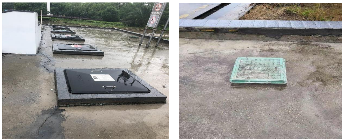
图 3-3 站区现有地下油罐及地下水监测井
