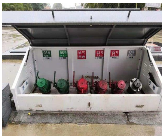
图 3-6 加油区、卸油区油气回收装置
