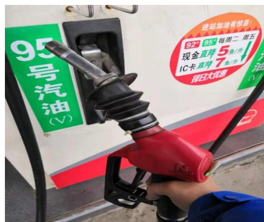
图 3-6 加油区、卸油区油气回收装置
