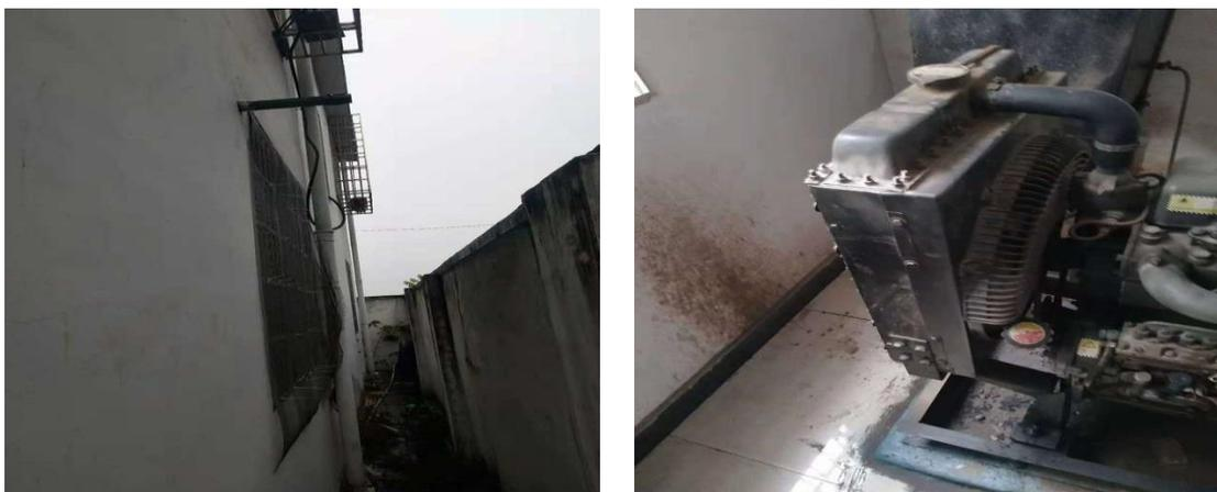
图 3-4 发电机房、发电机废气排放口
