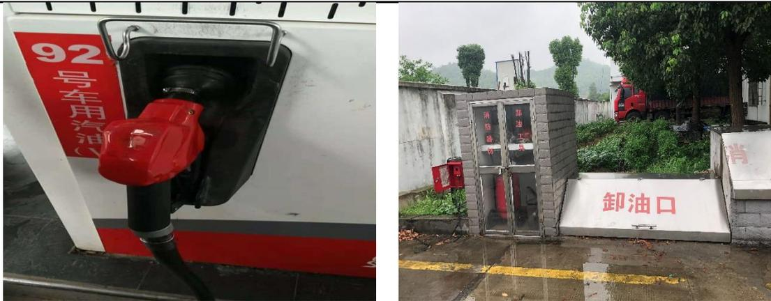
图 3-7 加油区、卸油区油气回收装置
