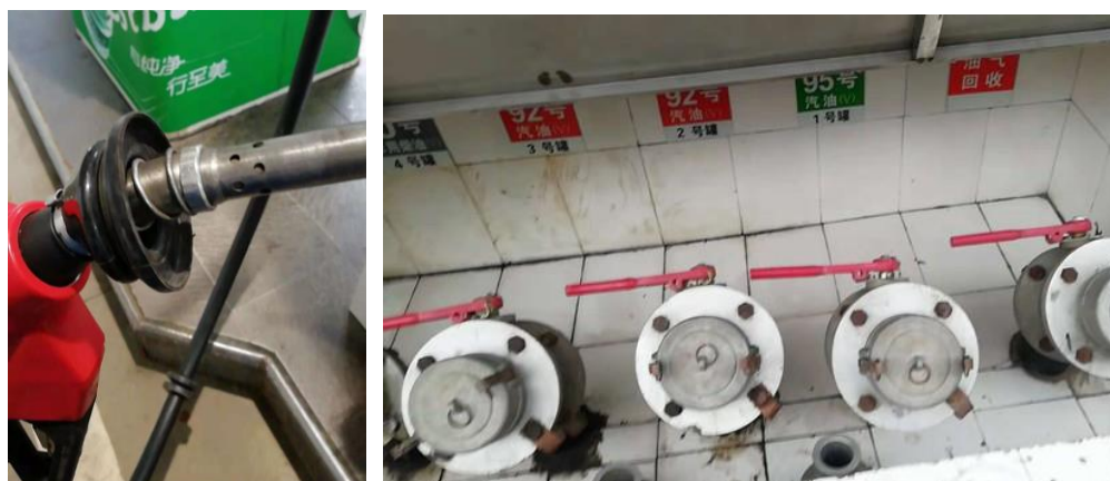
图 3-6 油气回收装置
