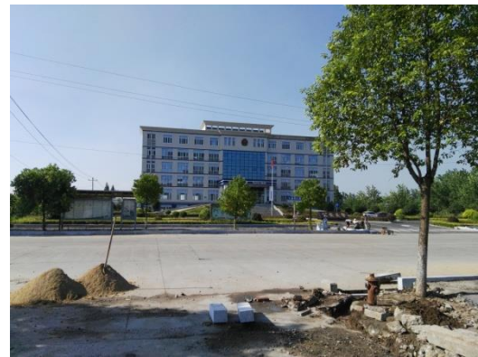
项目北侧（大通湖公安交警办公楼）
