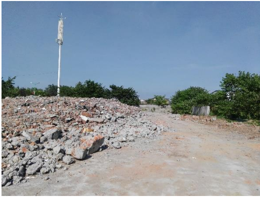
项目东侧（待建汽车站）
